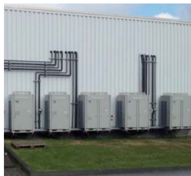
Sechs DAIKIN ZEAS-Außengeräte bieten eine Kühlleistung von 74 kW für den Tiefkühlbereich, während weitere sechs Einheiten eine Kühlleistung von 171 kW für die Kühlwarezone bieten.
